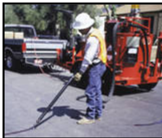
Figura 5. Sopleteado de la caja
