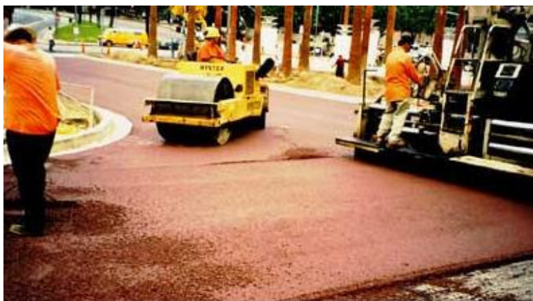
Figura 2.4: Colocación y compactación de la mezcla de color
